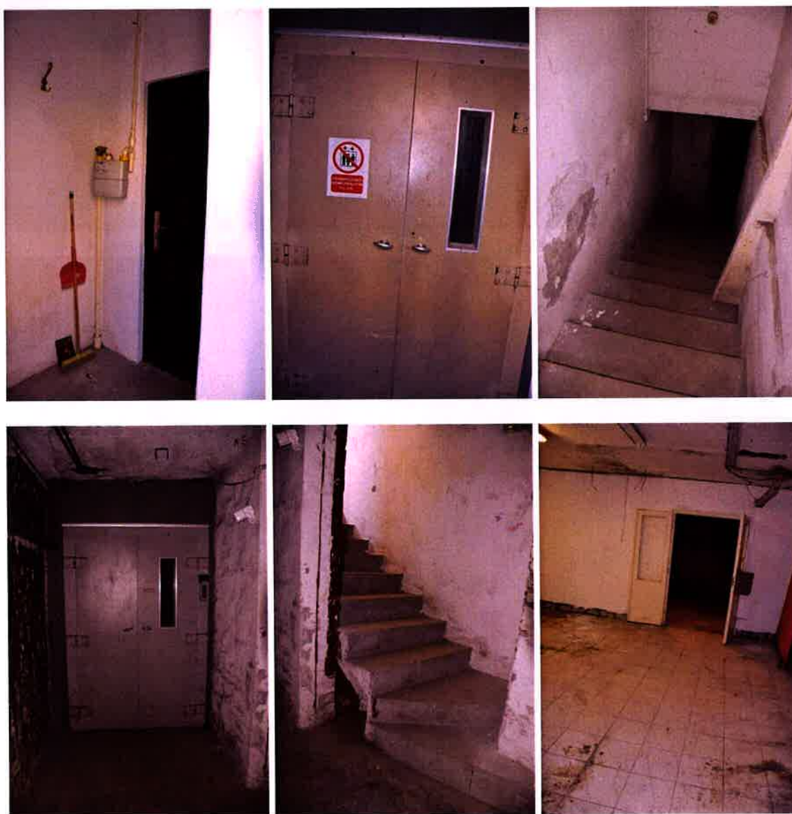
402 m 2 -es pincei rész képei a földszinti bejáráttal és a teherlifttel
