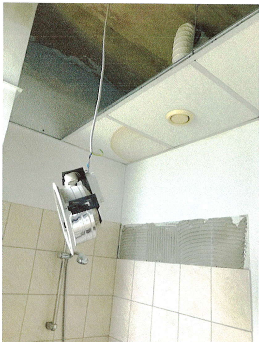
Megrongált szellőző berendezések
