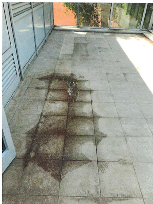
Lapostető csapadékelvezetés hibája miatti pangó víz
