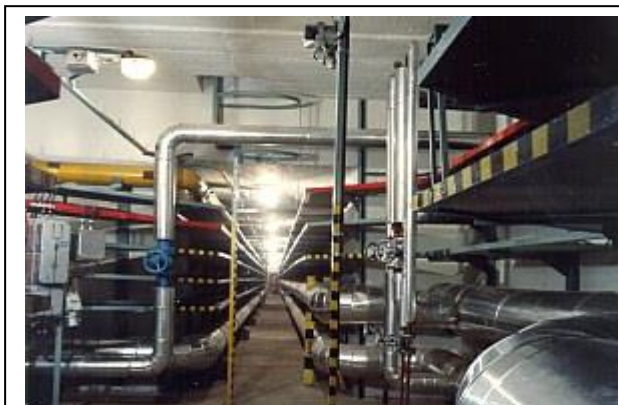
Pesterzsébeti lakótelepet ellátó térszín alatti hő-elosztó létesítmény, és közműalagút
