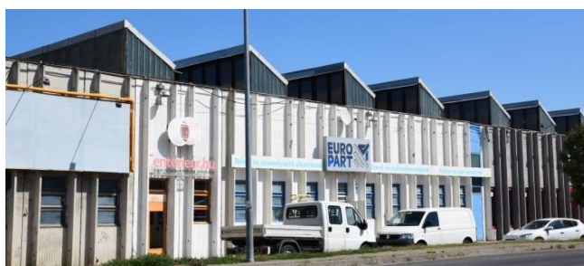
Shed-tető a repülőtéri útra néző raktárépületen
