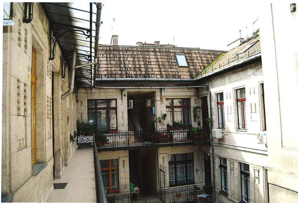
Befogadó épület, feljárt a padlásra
