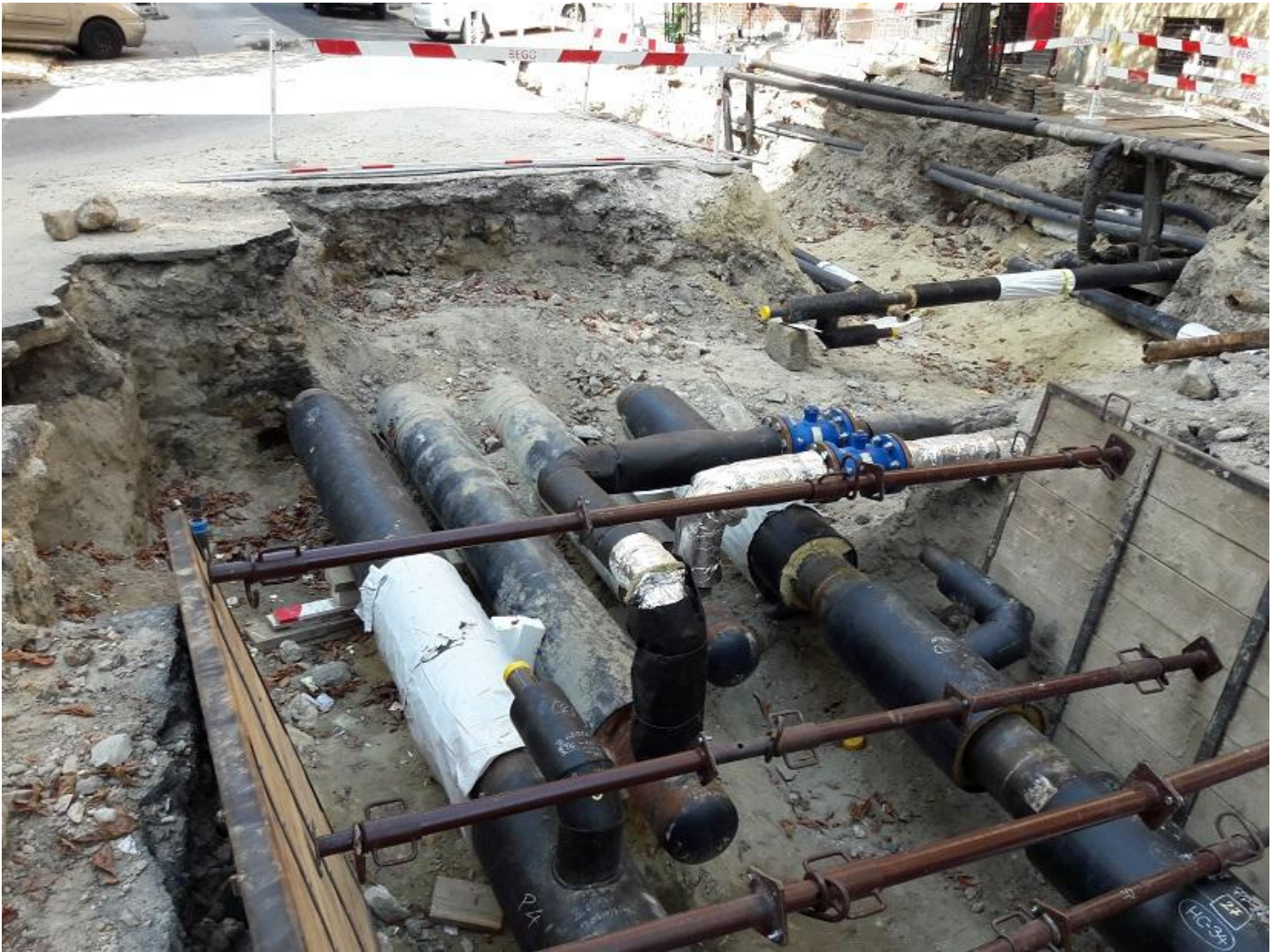
Bertalan Lajos u-Kende u keresztződés
