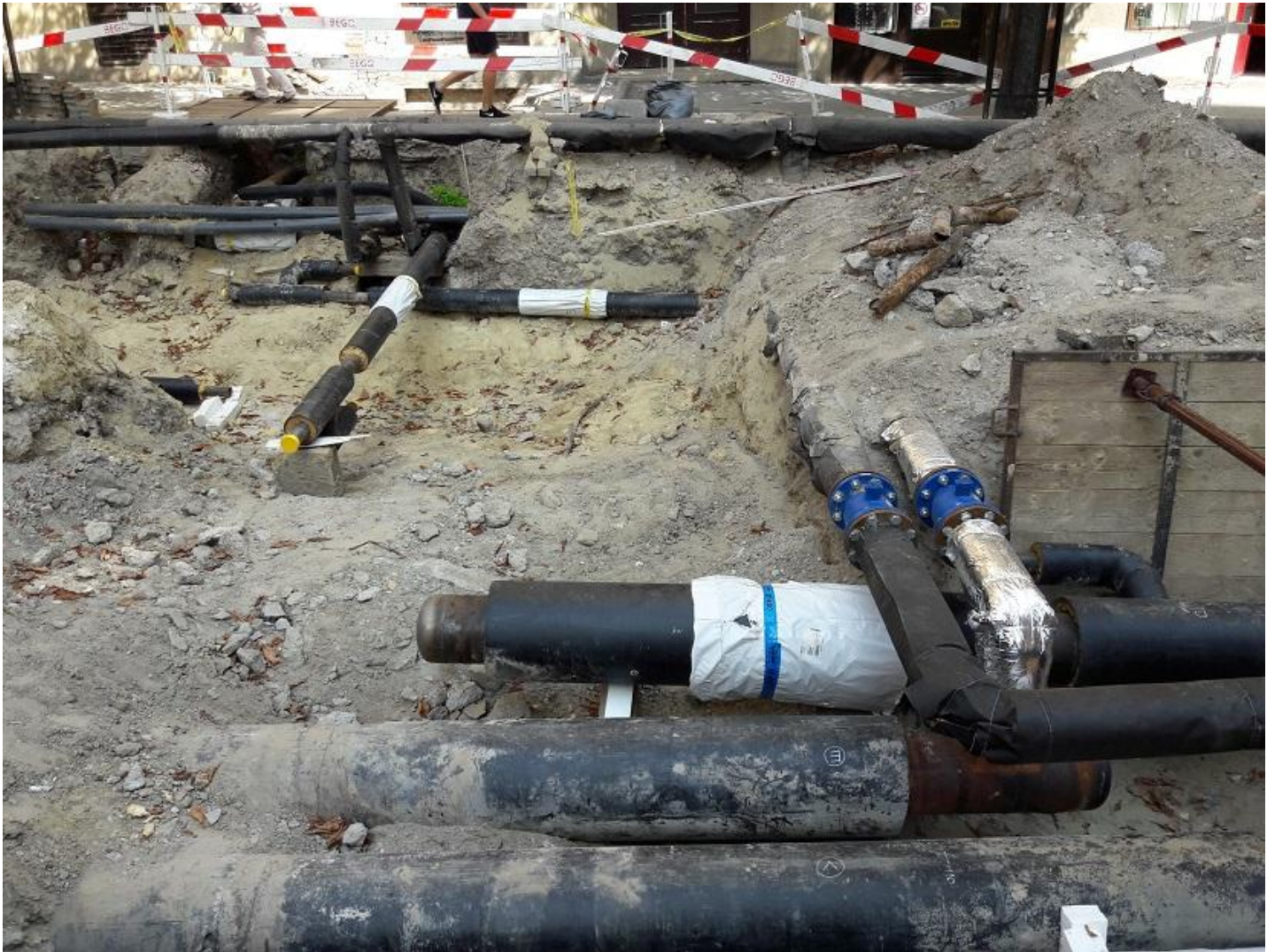
Bertalan Lajos u-Kende u keresztződés
