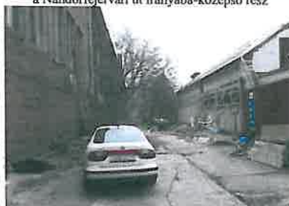
középső rész - szomszédos építkezés
